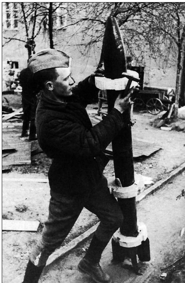
Изготовление летающих торпед. На корпус М-20 устанавливают деревянные кольца — шпангоуты для жестяного кокона. 1-й Украинский фронт, Бреславль, 29 апреля 1945 г.
