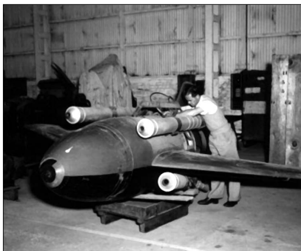
Реставрация музейного «Энциана». Видны стартовые ускорители.
