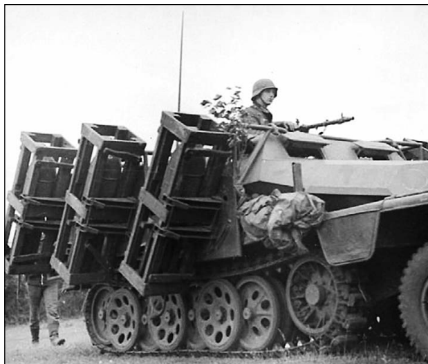
Укупорки с зажигательными снарядами 320-мм — Wk Flam на бронетранспортёре «251». Июнь — июль 1943 г. Фото: Дик, Федеральный архив ФРГ.
