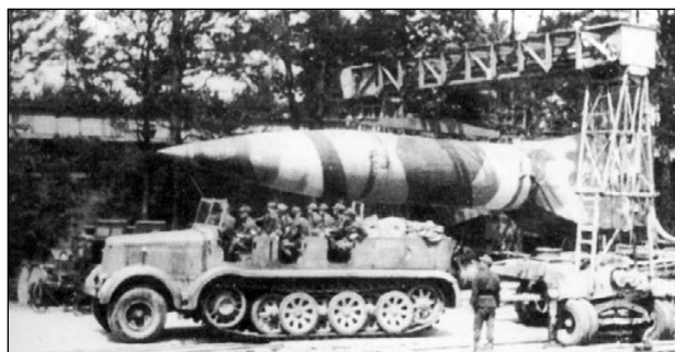
Боевая Фау-2 с помощью козлового крана устанавливается на тележку. Видны траверсы и ремни, с помощью которых выполняется подъём. На переднем плане — тягач с отделением охраны. Стартовая команда занята погрузкой.
