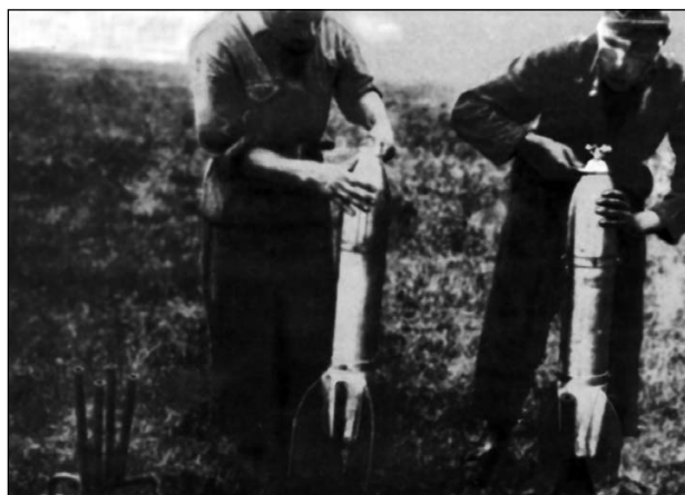
Подготовка РС-132 к боевому применению. Для удобства ракеты устанавливаются на подставки, сваренные из труб. Одна из них стоит на траве, слева. Бойцы устанавливают взрыватели, хотя по правилам это нужно делать после подвески ракеты на самолёт.
