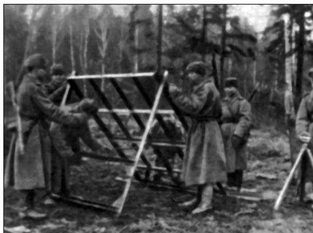
Рамный станок для запуска снарядов М-30 и М-31. Он был сварен из металлических уголков и имел простейшую конструкцию. Справа, возле бойца, виден теодолит – угломер, с помощью которого производилось прицеливание станка. Для этого на раме имелись специальные реперные уголки.
