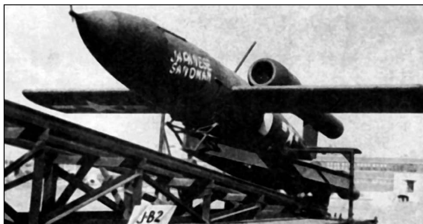
JB-2 — американская копия немецкой Фау-1. Ракета на демонстрационной площадке. Об этом говорит табличка JB-2 на ПУ. Хорошо видны стартовая установка, тележка и 4 ракетных ускорителя.
