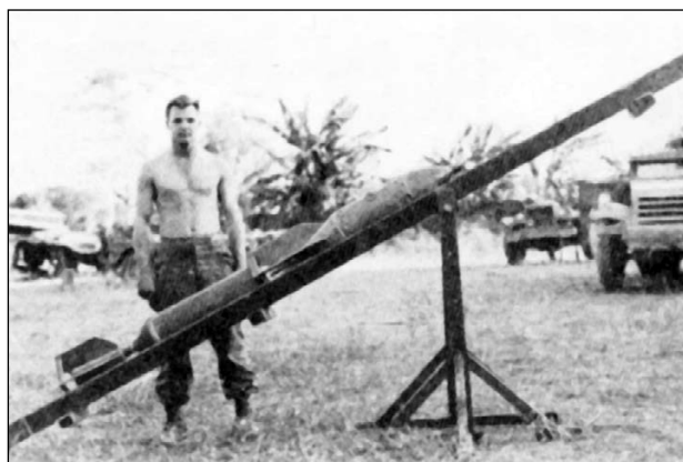
Бомба, калибром 250 кг, с ракетным ускорителем, установлены на пусковой установке.
