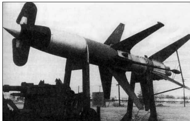
Ракета «Рейнтохтер R-1». Видны трассеры на законцовках крыльев, сопла маршевого двигателя, конструкция рулей и членение фюзеляжа на отсеки.
