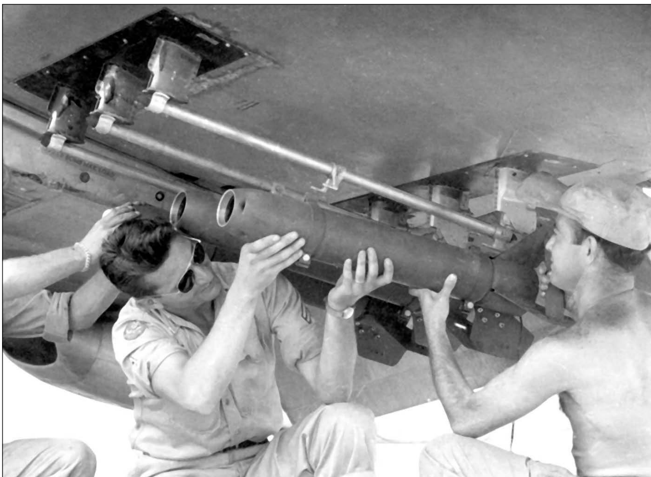
Реактивный снаряд М-8 с фиксированным хвостовым оперением.
