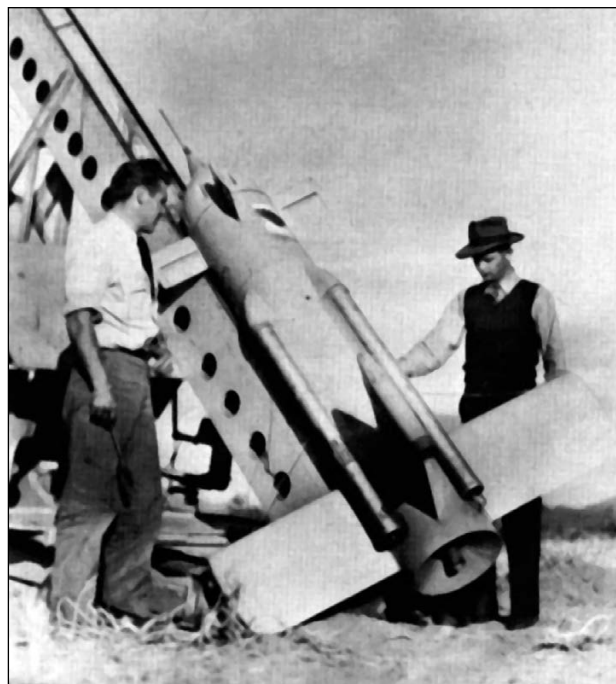
KAN-1 Little Joe на пусковой установке. Этот образец имеет острый нос с трубкой ПВД на конце. Полигон Поинт Мугу, 1945 г.
