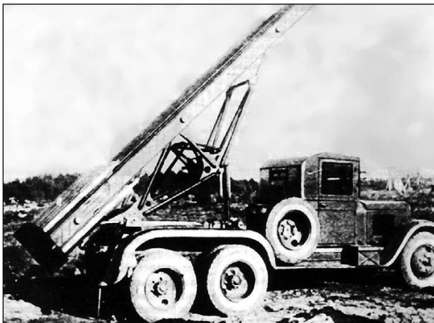
Установка МУ-2 (механизированная установка-2) для запуска реактивных снарядов М-13. Смонтирована на шасси грузовика ЗИС-5. В отличие от прототипа удлиненные направляющие расположили вдоль машины. Боекомплект при этом сократился до 16 ракет. На основе МУ-2 была разработана знаменитая установка БМ-13-16.
