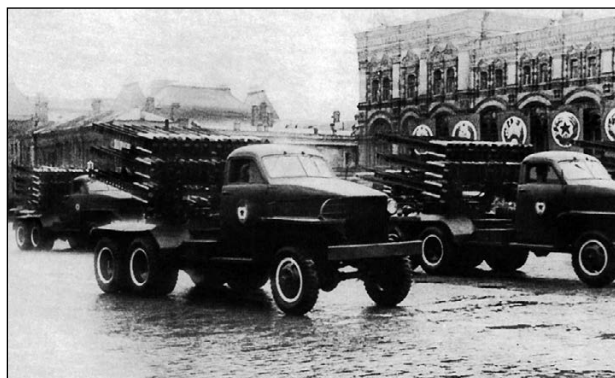
БМ-8-72 на шасси автомобиля «Студебекер» имела самое большое число направляющих – 72 штуки. Парад Победы, Москва, 24 июня 1945 г.
