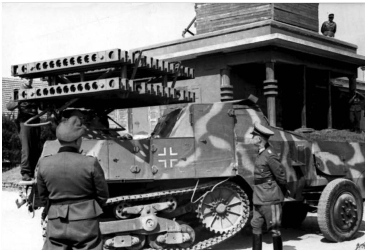
Пусковая установка из 24 спаренных пусковых балок монтировалась на шасси французского бронетранспортёра SOMUA MCL.
