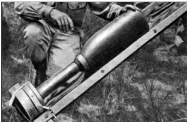
Мощная ракета Т-37, предназначенная для разрушения бункеров, имела калибр 183 мм. Для запуска она устанавливалась на простейшем деревянном лотке.
