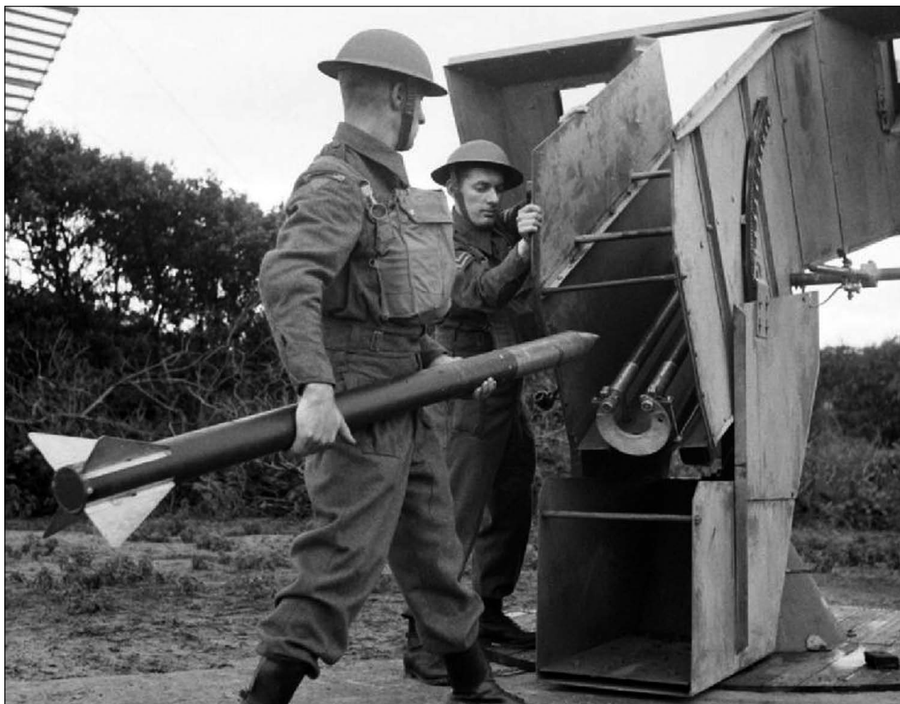
Солдаты Территориальной обороны загружают ракету типа «Z» в пусковую установку. Стрелки располагаются по обе стороны от направляющей и защищены металлическими экранами. Один стрелок наводит ПУ по горизонтали, а другой — по вертикали. Зенитная батарея возле г. Мерсисайд, июль 1942 г.
