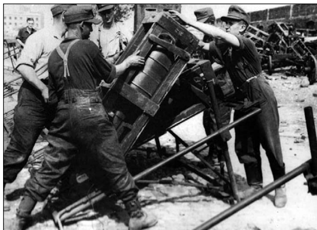
Установка укупорки с 32-см зажигательным снарядом в рамную пусковую установку.
