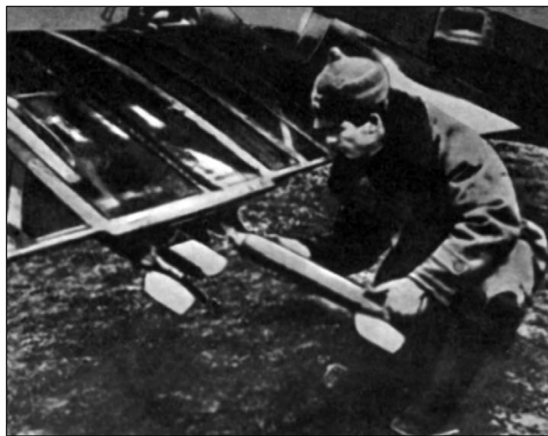
Один из первых вариантов реактивных снарядов РС-82 во время испытаний. Боевая часть без насечек. 1938 г.
