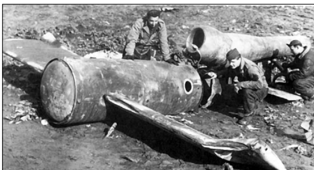
V-1, сбитый над Францией. Боевая часть разрушилась при падении. Видна передняя стенка топливного бака.
