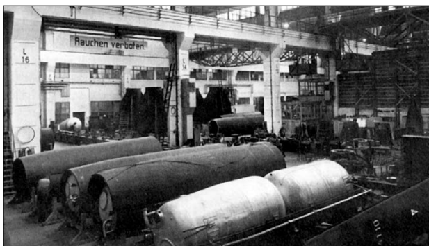
Средние отсеки ракет в сборочном цехе базы Пенемюнде. На переднем плане видны алюминиевые баки для кислорода и спирта, а также трубопровод, с помощью которого проверяется их герметичность. На втором плане баки уже покрыты теплоизоляцией и заключены в обшивку.
