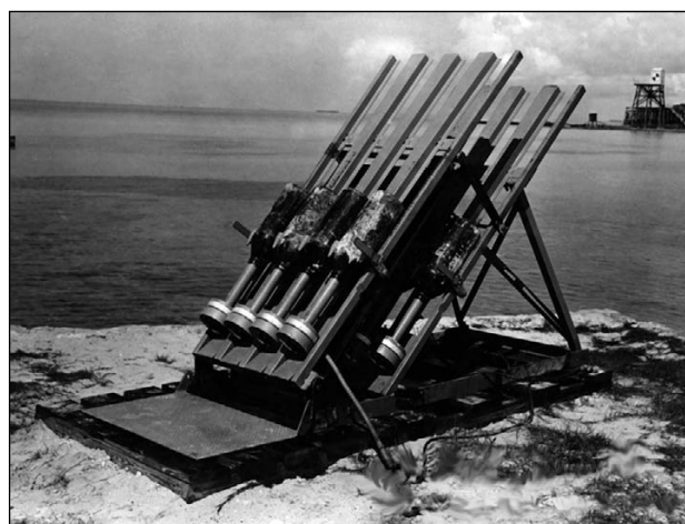
Экспериментальная противолодочная реактивная установка. Морской полигон Кэй Вест, Флорида, США, 14 августа 1942 г.
