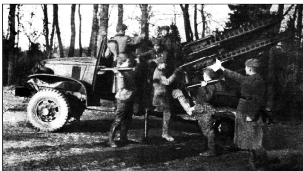
Расчёт заряжает БМ-8-48 на шасси автомобиля «Шевроле G-7117». Два бойца на плечах держат снаряды М-8. 54-й ГМП, осень 1944 г.
