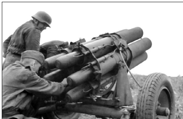
Пусковая установка, заряженная 150-мм снарядами, на огневой позиции. Хорошо видны боевые части ракет, выступающие за контур направляющих труб. Лето 1942 г. Фото: Нейберле, Федеральный архив ФРГ.
