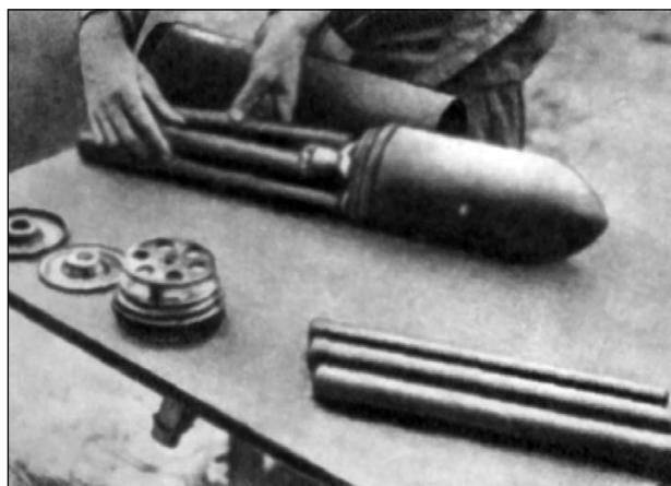
Сборка 100-мм ракеты в полевых условиях. На переднем плане – топливные шашки, чуть поодаль – сопловой блок с колосниковой решёткой.
