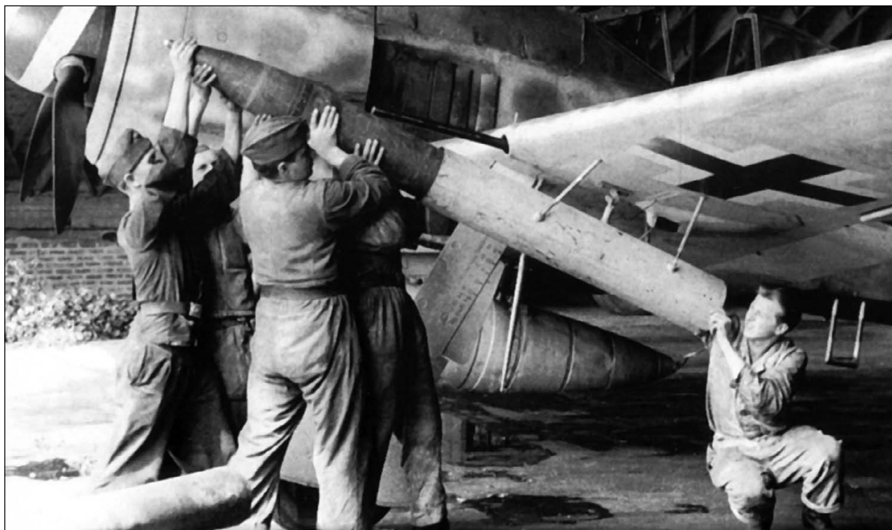
Заряжание ракеты WGr 21 в пусковую установку «Рустзац 6», установленную под крылом Fw 190. Виден крючок бомбодержателя, на котором висит ПУ. Четыре распорки с резиновыми наконечниками фиксируют трубу и позволяют регулировать направление её оси. После выстрела установку можно сбросить.
