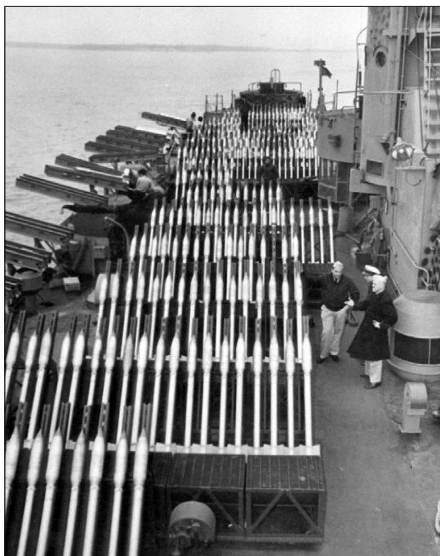
Большой десантный корабль LSM(R), вооружённый авиационными ракетами AR-HE калибром 127 мм, приспособленными для стрельбы по берегу.
