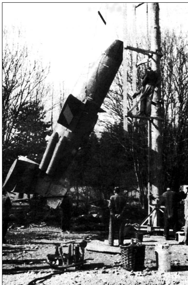
Опытный экземпляр Ba-349 устанавливают на пусковую установку типа «столб». Под крылом нанесён белый прямоугольник для облегчения визуального слежения за полётом. Обратите внимание на два сосуда на переднем плане: в стеклянной бутылке (в оплётке) хранилась перекись водорода (Т-штофф), а в алюминиевом бидоне – горючее (С-штофф). Эти компоненты самовоспламеняющиеся, так что эти сосуды нужно хранить как можно дальше друг от друга. Вместе их поставили для фотографирования.
