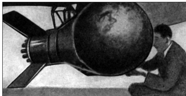
Прыгающая бомба с ракетным ускорителем SB-800 «Курт» в процессе подготовки к полёту.
