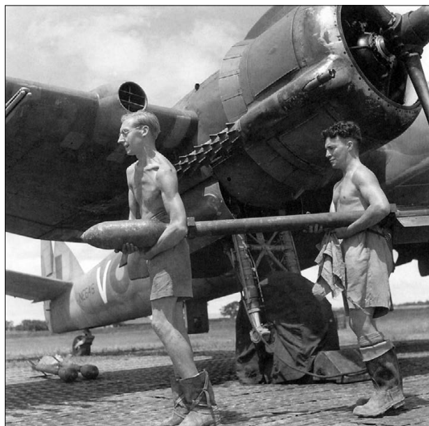
Подготовка ракет с 27-кг осколочно-фугасной боевой частью для подвески на самолёт Бофайтер. Ещё две ракеты лежат на земле в тени крыла. Колесо закрыто чехлом, чтобы покрышка не растрескалась под лучами жаркого солнца. Дальневосточный театр военных действий. Обратите внимание на одежду вооруженцев – шорты (жарко всё-таки) и массивные резиновые сапоги. Почему обуты именно они – непонятно.
