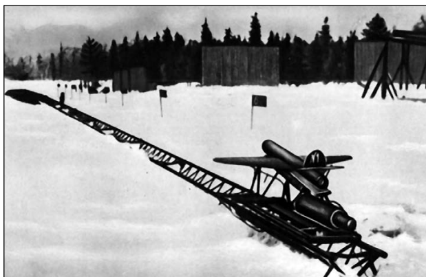
Крылатая ракета «212» на старте. Хорошо видны рельсовые направляющие, стартовая тележка и мощный твёрдотопливный ускоритель. На ракете виден подкос, поддерживающий стабилизатор. 1937... 1939 гг.
