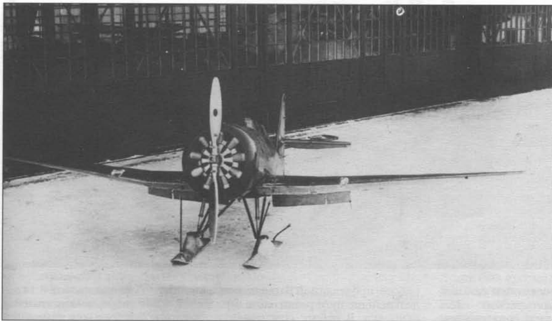
Цельнометаллический истребитель И-14бис с мотором «Райт Циклон» проходил испытания в марте-мае 1934 г. В отличие от первого опытного образца он имел крыло и хвостовое оперение с гладкой обшивкой.
