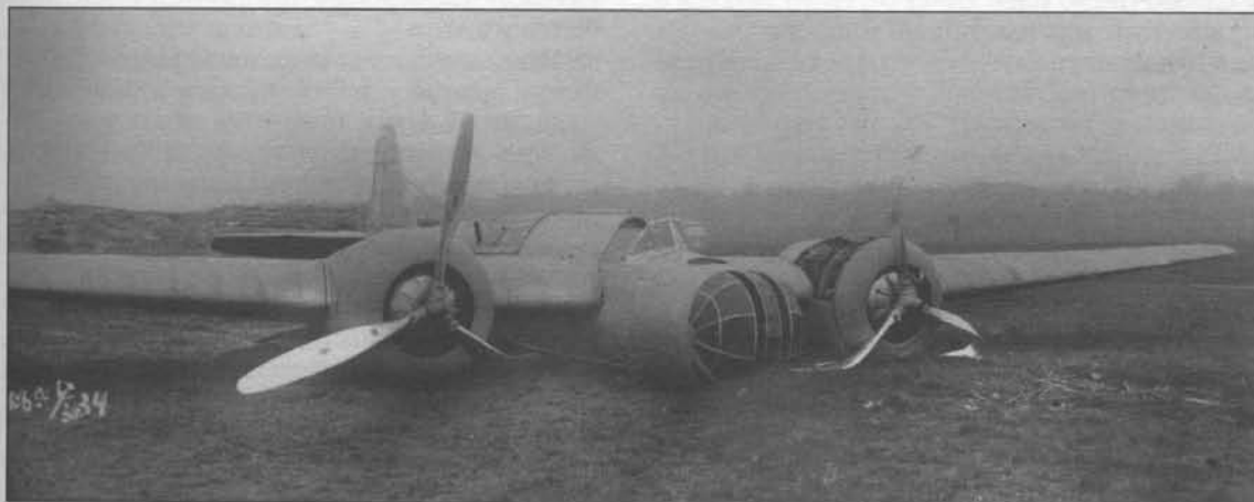
Бомбардировщик СБ осенью 1934 года существовал в одном опытном экземпляре с моторами Райт Циклон и 31 октября потерпел аварию во время испытаний.
