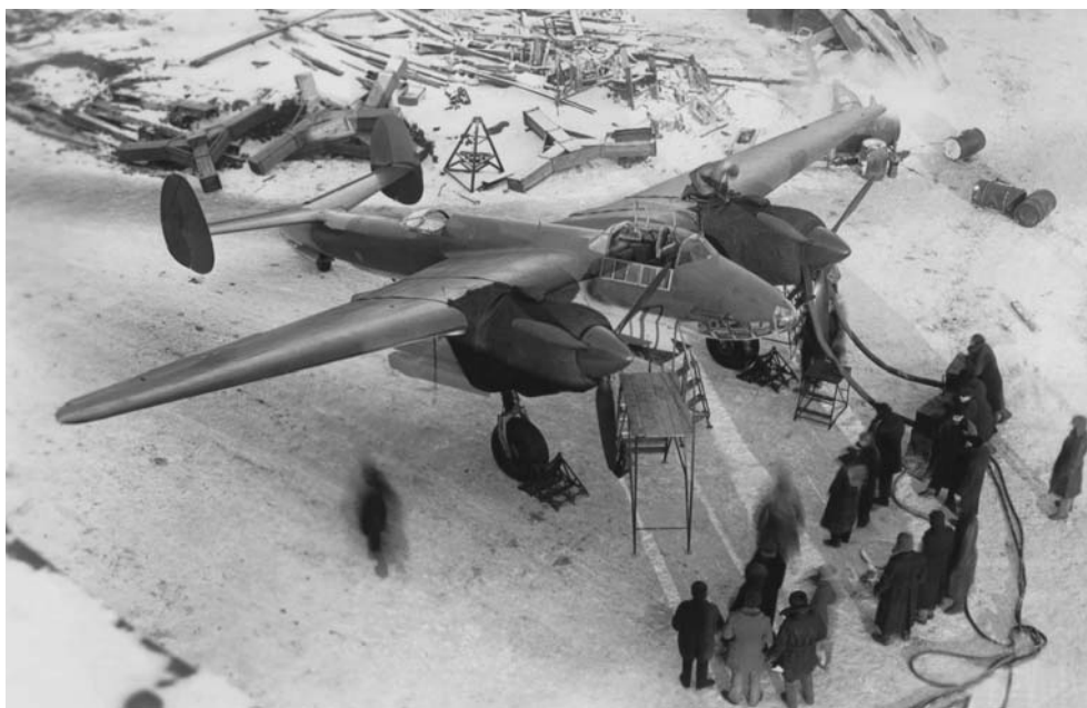
Прогрев двигателей бомбардировщика Ту-2 во дворе авиазавода
