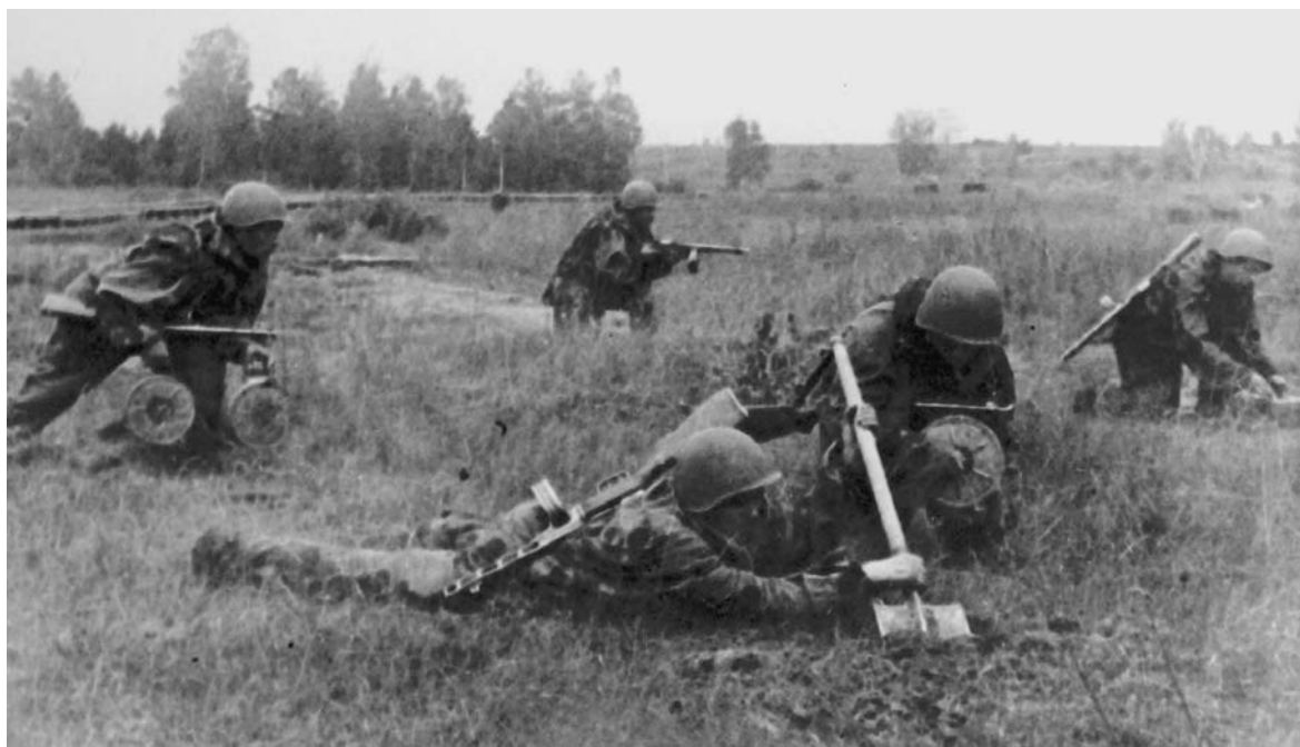
Саперы устанавливают противотанковые мины ТМ-42 на подступах к переднему краю обороны на Курской дуге
