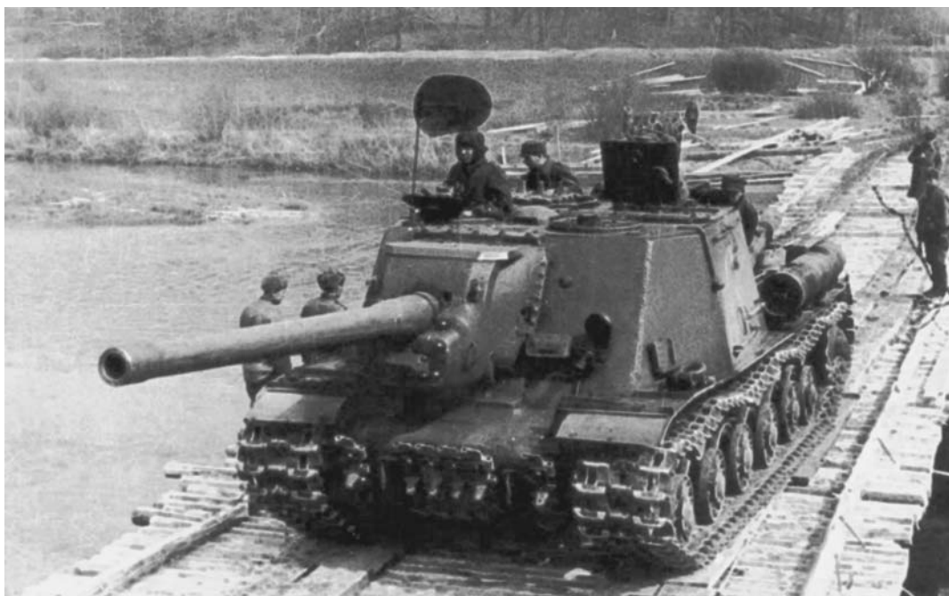
САУ ИСУ-122 1-го танкового корпуса Войска Польского переправляется по понтонному мосту
