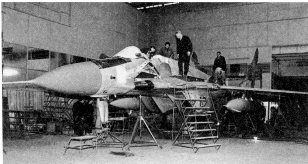
Сборка второго прототипа МиГ-29К
