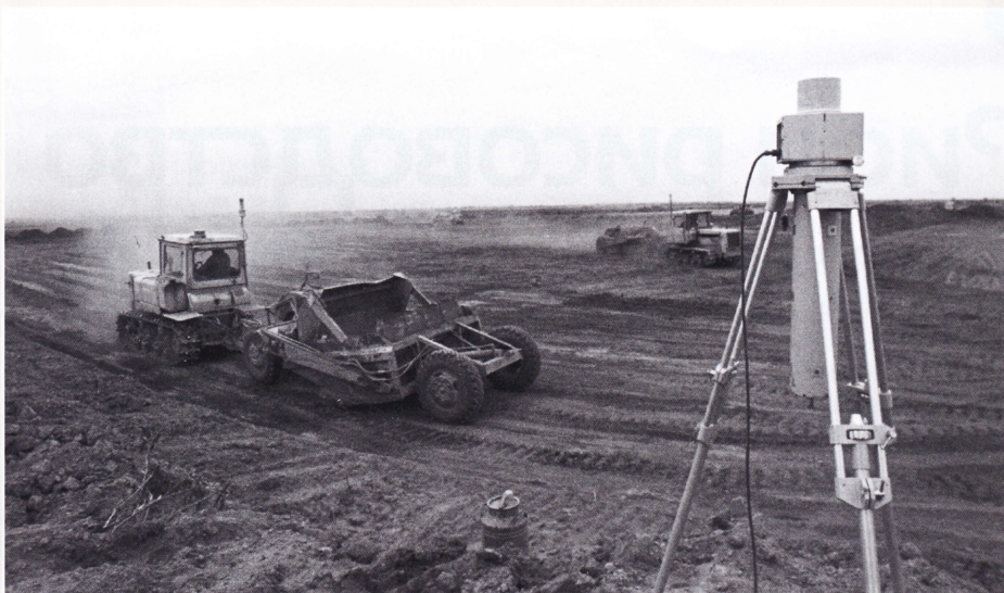
Планировка рисовых полей скреперами с помощью лазерной установки «Калина». 1982 г.
