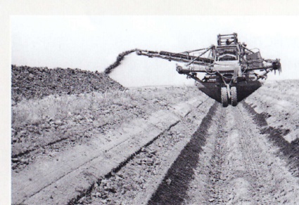
Нарезка оросительных каналов роторным экскаватором на рисовых полях совхоза Петровичанского. Приморский край. 1982 г.
