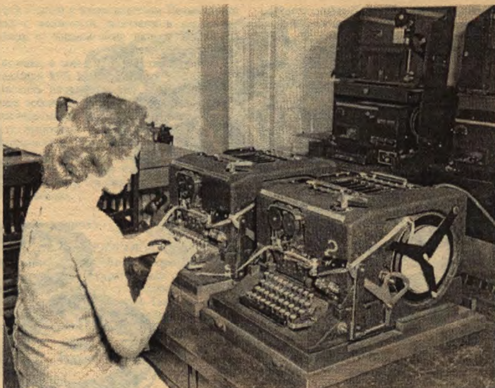
Две спаренные машины «Сигаба»; дисковая «корзина» в верхней части корпуса (АГЕНТСТВО НАЦИОНАЛЬНОЙ БЕЗОПАСНОСТИ)
