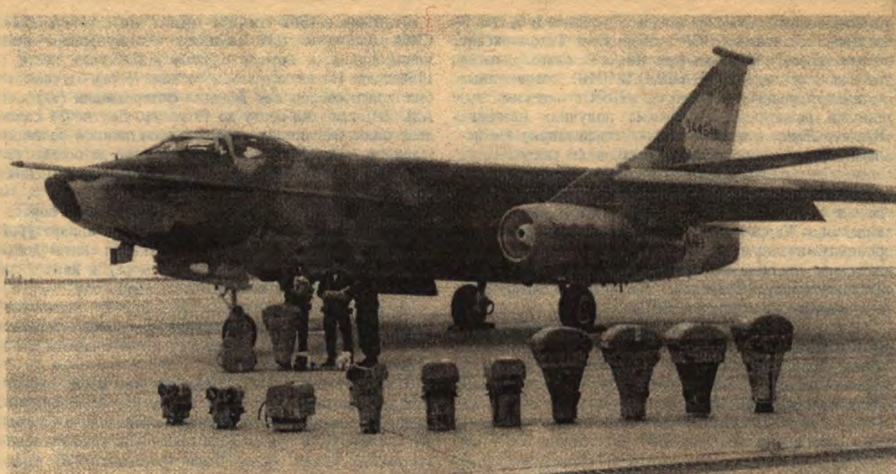
Разведывательная модель A3D-2P самолета морской авиации США «Скайуорриор», 12 бортовых фотокамер и 3 члена экипажа (ВМС США)
