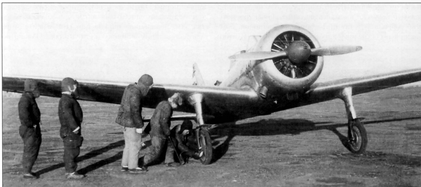
Колеса передка накачивали велосипедными насосами. Приходилось очень долго качать, сменяя друг друга
