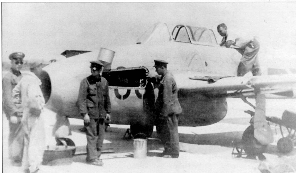
Слева: Регламентные работы на учебно-боевом истребителе УТИ Як-17 совместно проводили советские и китайские техники. Аэродром Цзянвань, осень 1950 г. На стр. 309: УТИ Як-17 в Пекинском авиационном музее Датаншань
