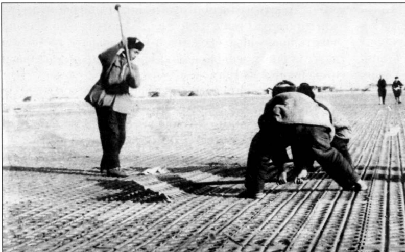
Китайские военнослужащие ремонтируют полевые аэродромы из металлических полос
