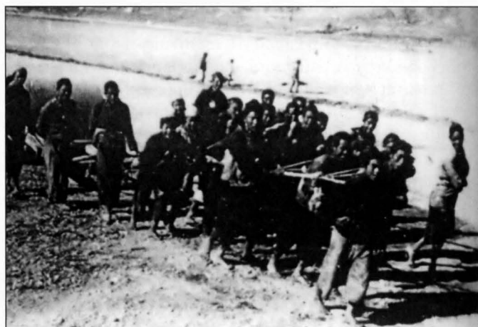
Китайцы готовят аэродромы для В-29. Работа идет вручную... (слева) и с помощью «каменной механизации» (каток весил около 12 т). Конец 1943 г.
