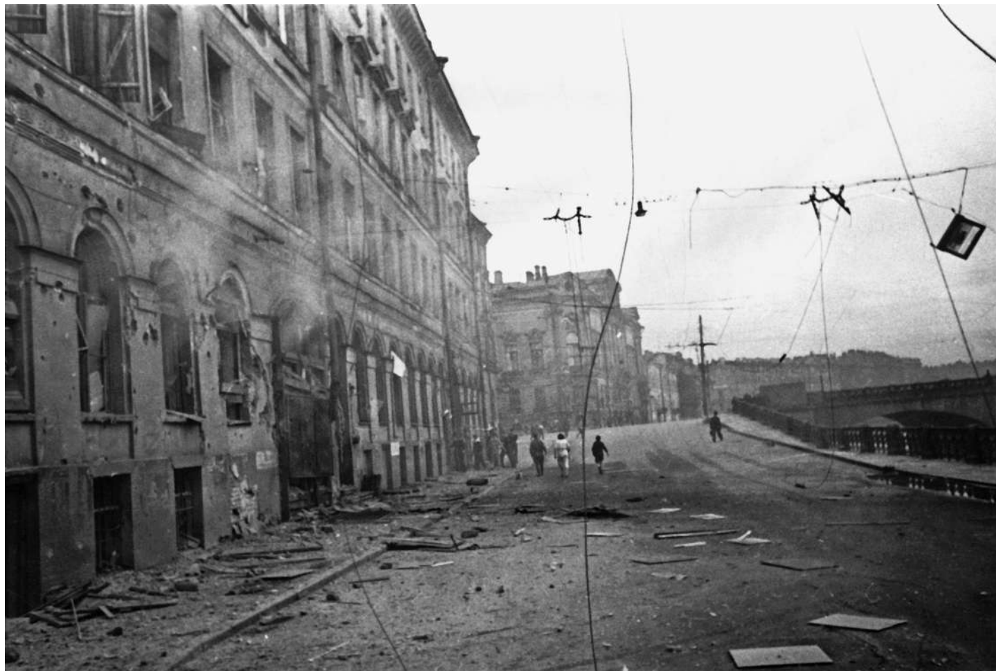
▲ Повреждения после очередного артиллерийского обстрела на набережной Фонтанки у Аничкова моста. Ударной волной выбиты фанерные листы из окон, оборвана контактная сеть. Осколками побита штукатурка на стенах дома. 1942–1943 годы.
