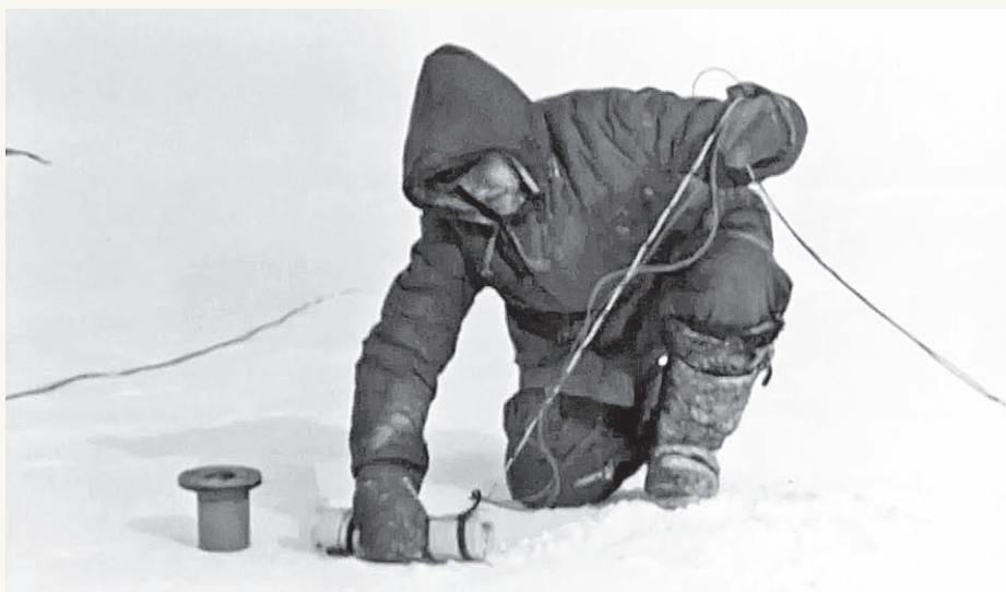
▲ Во время санно-гусеничного похода гляциологи закладывают взрывчатку для проведения сейсмических работ
