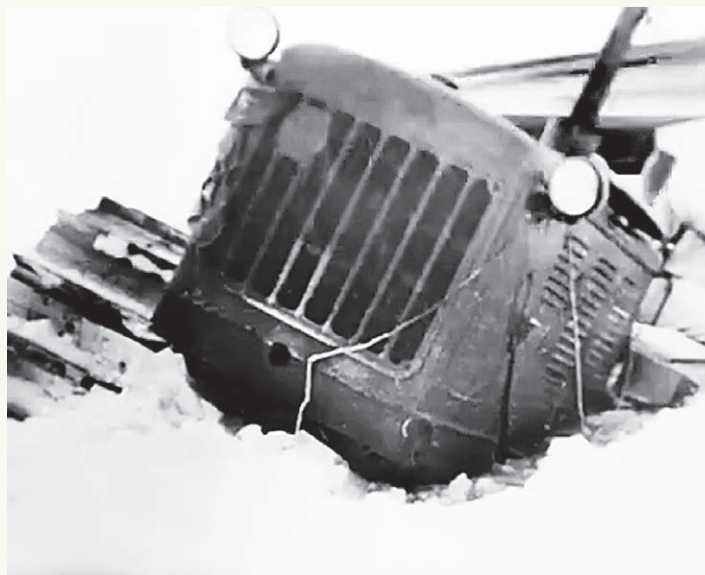
▼ Тракторы, провалившиеся в ледяные полыньи во время разгрузочных работ
