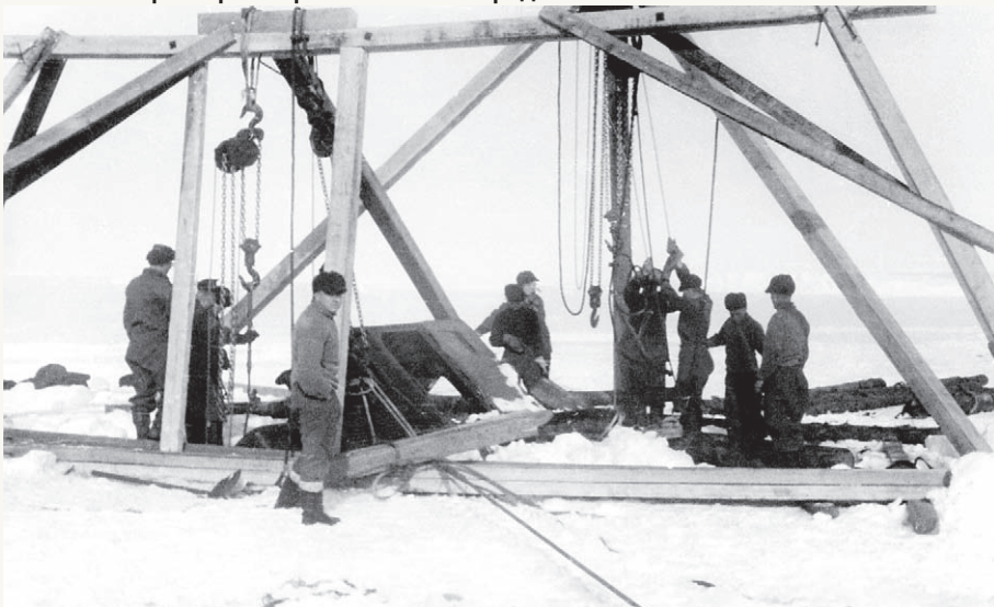
▼ Участники экспедиции с помощью талей вытаскивают провалившийся в полынью трактор. Из архива М.Е. Виноградова
